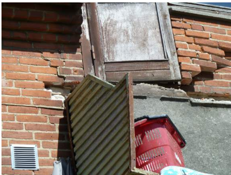
Figur 4 Udstøbning under døråbning
