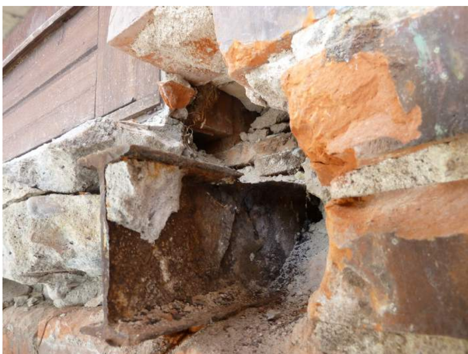
Figur 12, Før ophugning ved udliggerjern, altan i stueetage.
