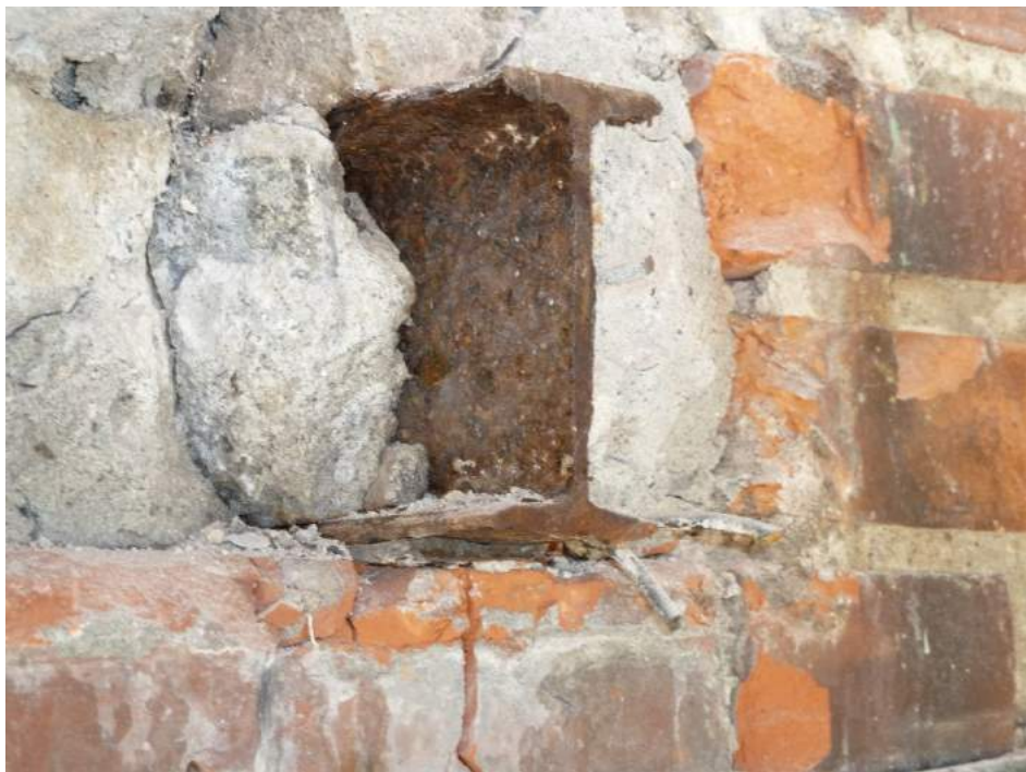
Figur 12, Før ophugning ved udliggerjern, altan i stueetage.
