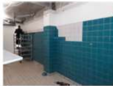
Påbegyndt nedtagning af fliser
