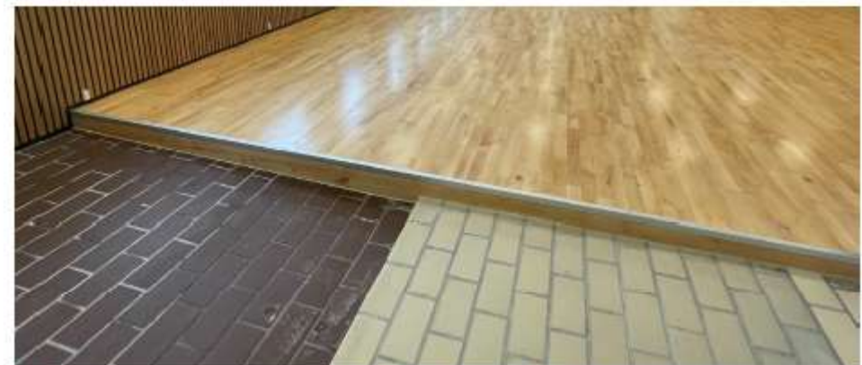
Strøsystemet optager de niveauspring der er i det underliggende klinkegulv
