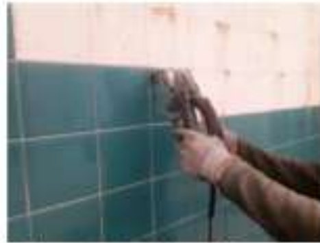
Anden metode ved brug af finecutter: Resultat: Ud af 40, kom 25 hele fliser af
