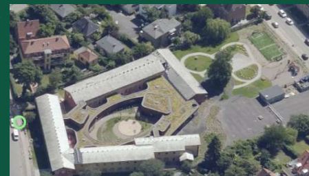
Heerup Skole CLT-byggeri
