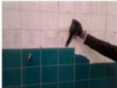
Første metode ved brug af mejsel: Ridse fugen af og derefter slå flisen af. Resultat: 128 hele fliser
