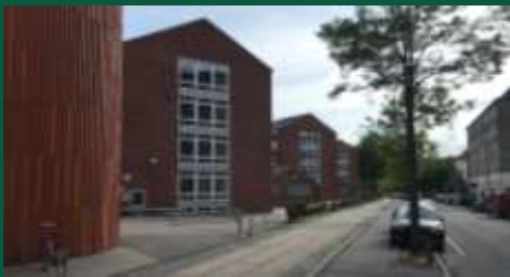
De Gamles Bys Skole Selektiv nedrivning
