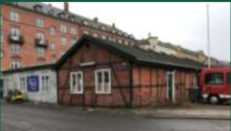
Center for Diabetes Selektiv nedrivning Træbyggeri
