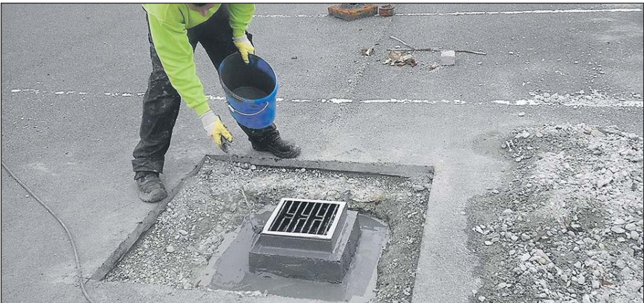
De PMMA-membraner, som Decorativa arbejder med, og som de vil vise frem på Netværksdagen, er 100% vandtætte og revneoverbyggende i henhold til den tyske standard OS10.
