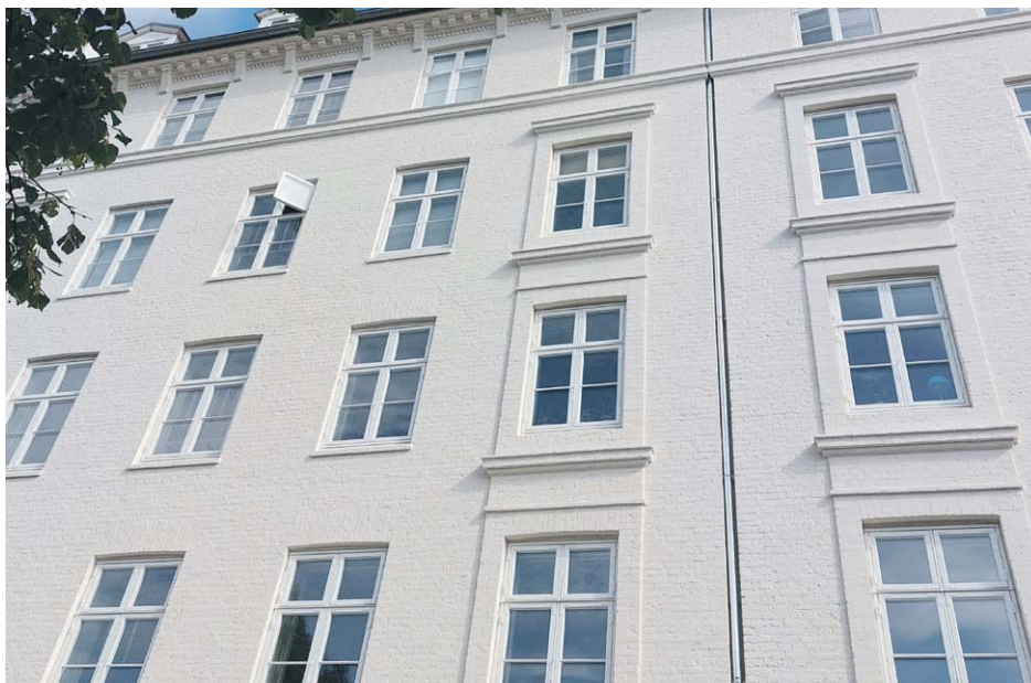
Facaden med de nye vinduer, Overgaden Oven Vandet 34 A-B.
