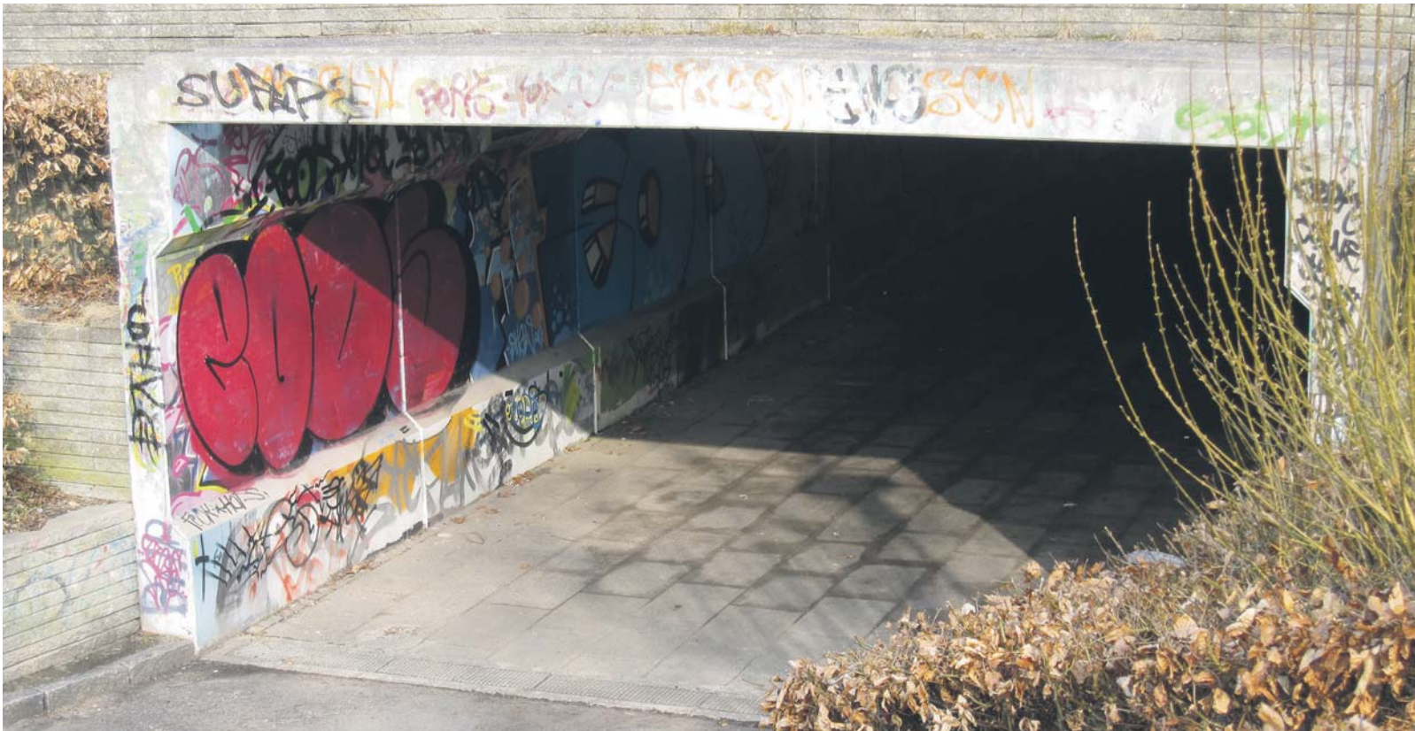
En gangtunnel kan virke lidt uhyggelig, uanset at der aldrig sker noget slemt i den. Regeringen vil nu give boligforeninger adgang til videoovervågning i sådanne tilfælde. Arkivfoto: Colourbox.dk
